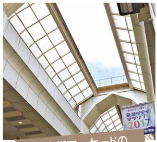
商店街アーケードの 屋根は開閉式
