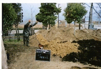
▲土壌改良の様子 上：根鉢を残して掘削したところ。 下：掘削した部分に改良した土を入れる。
