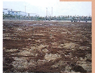
○地盤の整地 まだ寒さの厳しい中、芝張り作業に間に合うよう、トラクターで耕運を行いました。
